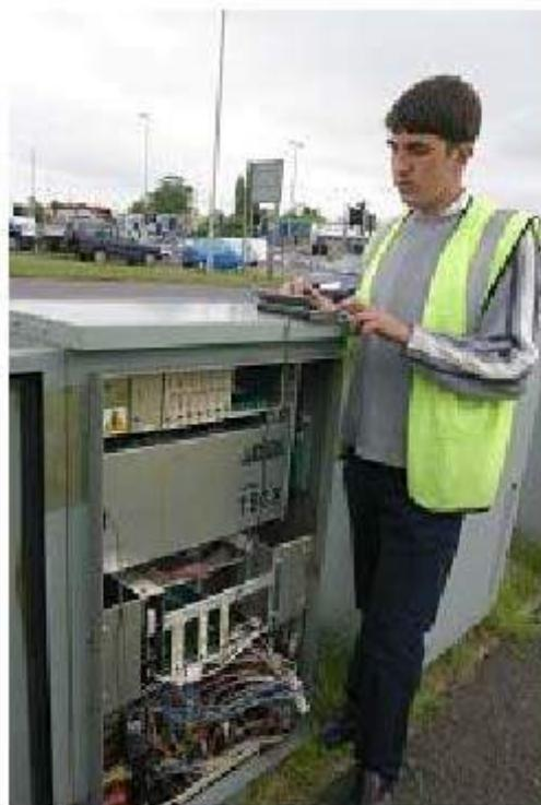
شکل ۴-۳- بازررسی از تابلوی برق سیستم روشنایی
