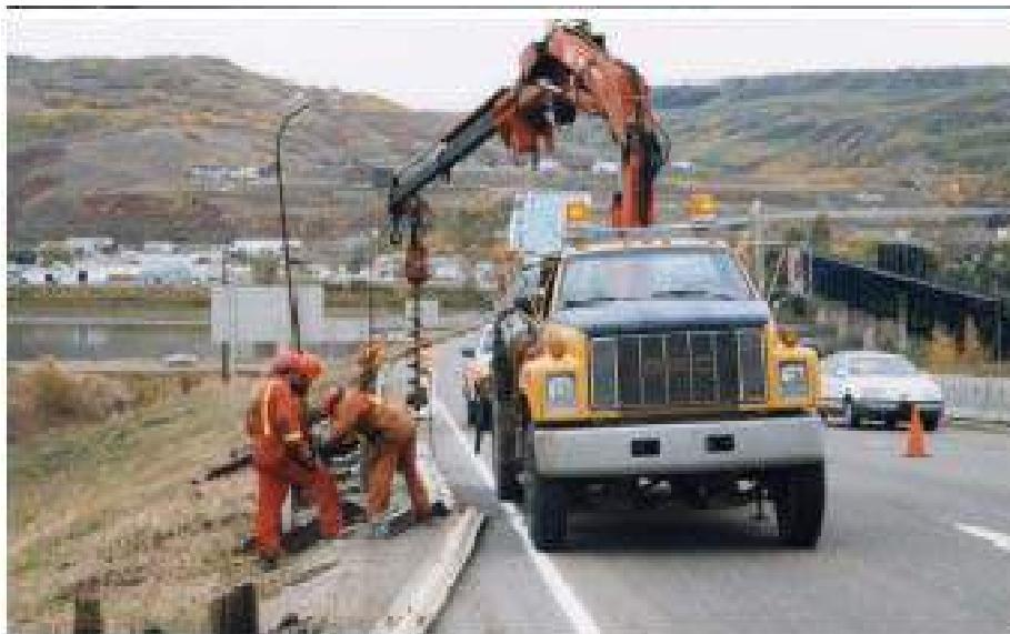
شکل ۴-۱- عملیات تعویض حفاظ فولادی
