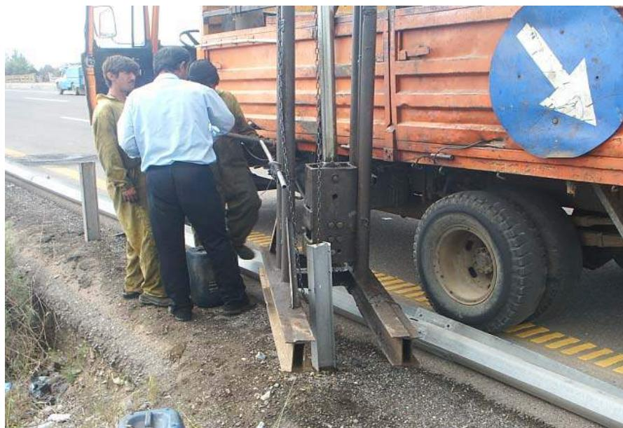
شکل ۴-۲- عملیات نصب پایه حفاظ فولادی
