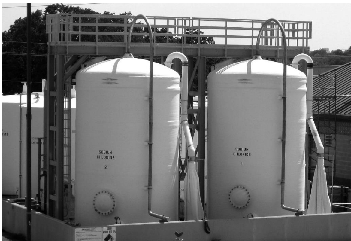
شکل ۲-۲- نمونه‌ای از مخازن FRP ویژه‌ی محلول آب نمک
