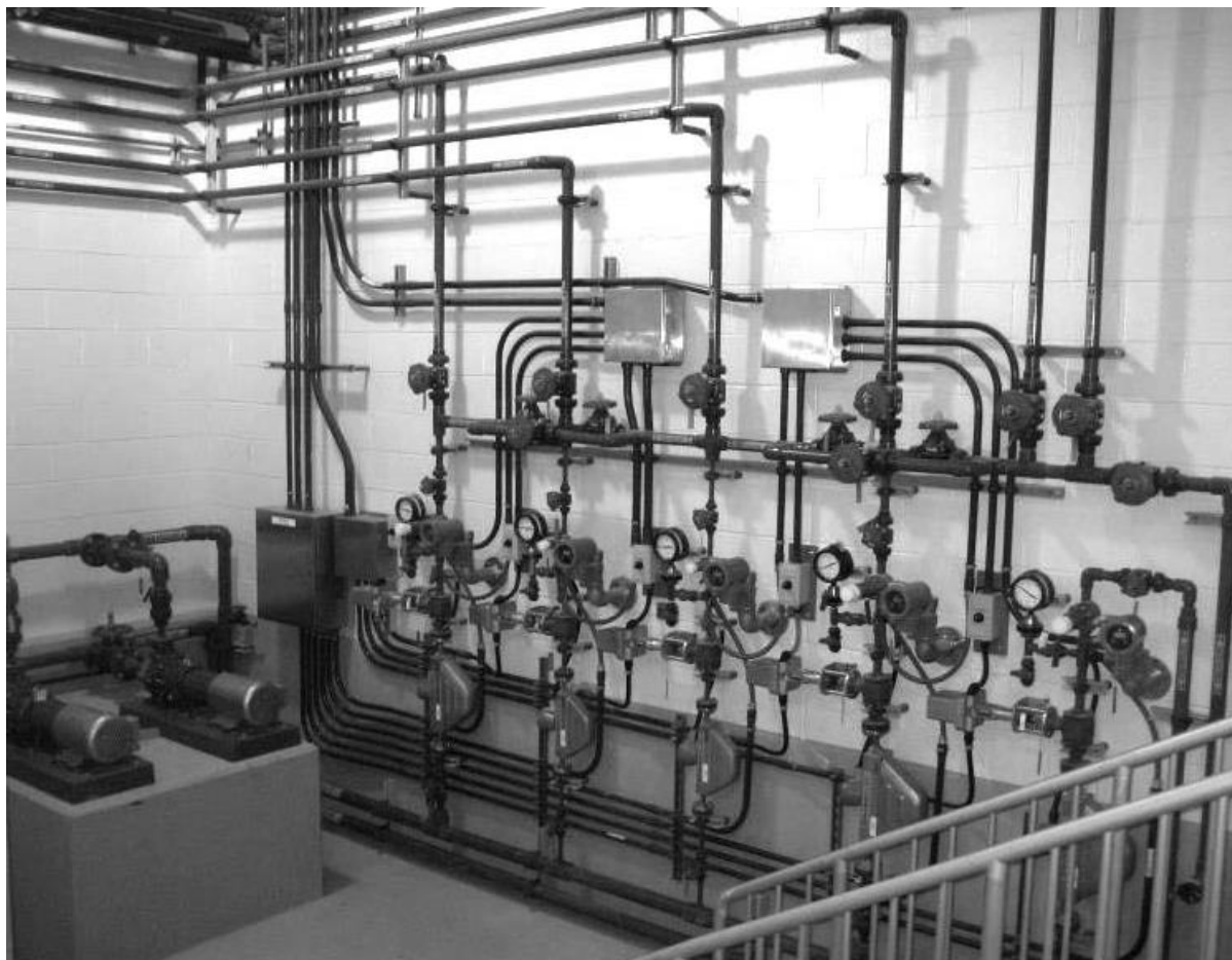
شکل ۲-۴- ایستگاه پمپاژ محلول از طریق طریق پمپ‌های سانتریفیوژی کوپل مغناطیسی ۱
