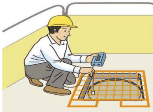
شکل ۱۳) پایش و اندازه‌گیری گازهای خطرناک قبل از ورود به آدمرو به وسیله دستگاه آشکارساز (دکتور)
